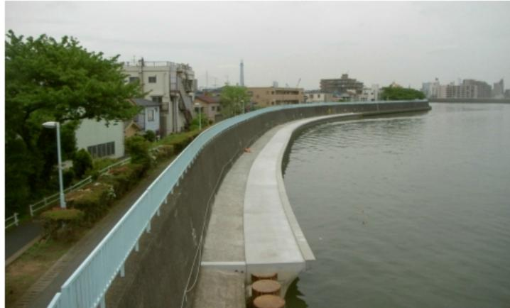
テラス型護岸(施工図)と完成写真
